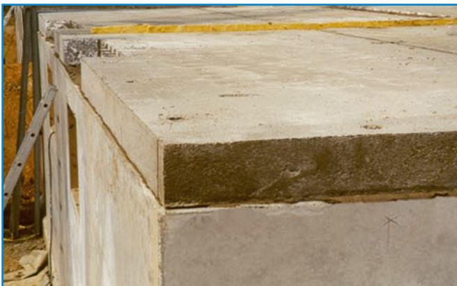
Euro-MX-Deckensystem auf Doppelhäusern mit integriertem Ringanker
