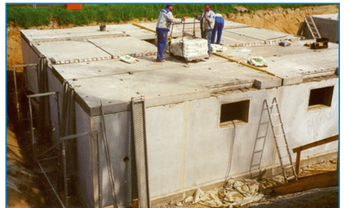
Euro-MX-Deckensystem auf Doppelhäusern mit integriertem Ringanker im Detail
